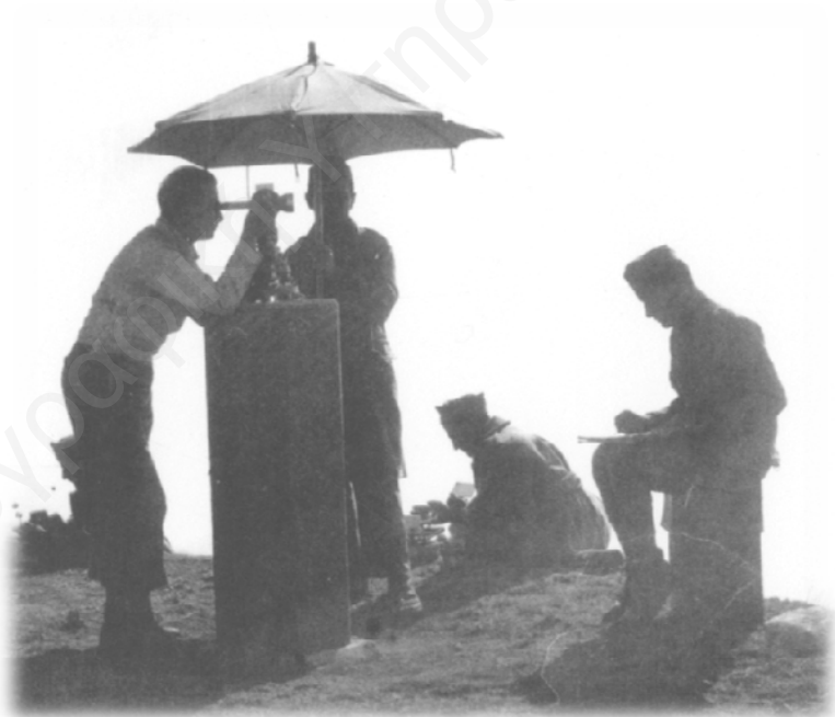
Γεωδαιτικές μετρήσεις σε τριγωνομετρικό βάθρο
