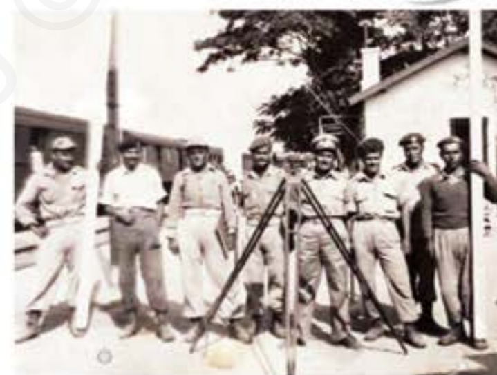
Εργασίες χωροσταθμικής υψομετρίας στην Τανάγρα
